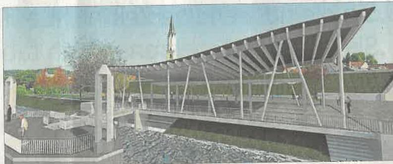
**Eine luftige Konstruktion** wird die Donauwelle, wie die Visualisierung des Architekten zeigt. Die Grundplatte ist 13 mal 26,5 Meter groß. Das Dach misst an der höchsten Stelle 6,85 Meter. Darunter ist Platz für ein flexibles Innenmodul aus Stoffbahnen, das an ein Bierzelt erinnert. – F.: PNP
