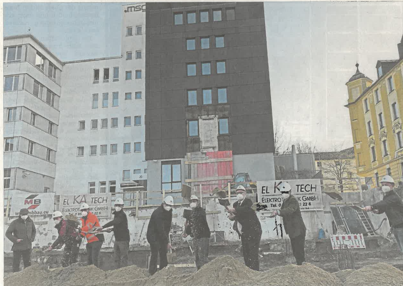
„Ran an die Spaten!“, hieß es gestern Nachmittag auf der Baustelle an der Firmianstraße: (v.l.) Bauunternehmer Matthias Bauer, Polier Franz Leeb, Bauleiter Ludwig Pelzeder, Architekt Thomas Schmitt von Friedl & Partner, Projektleiter Rudi Ramelsberger, Investor Michael Kapfinger, Oberbürgermeister Jürgen Dupper, msg-Passau-Leiter Dr. Armin Bender und Bauleiter Thomas Bauer vom Ingenieurbüro Fesl + Bauer. – Foto: Fischer
