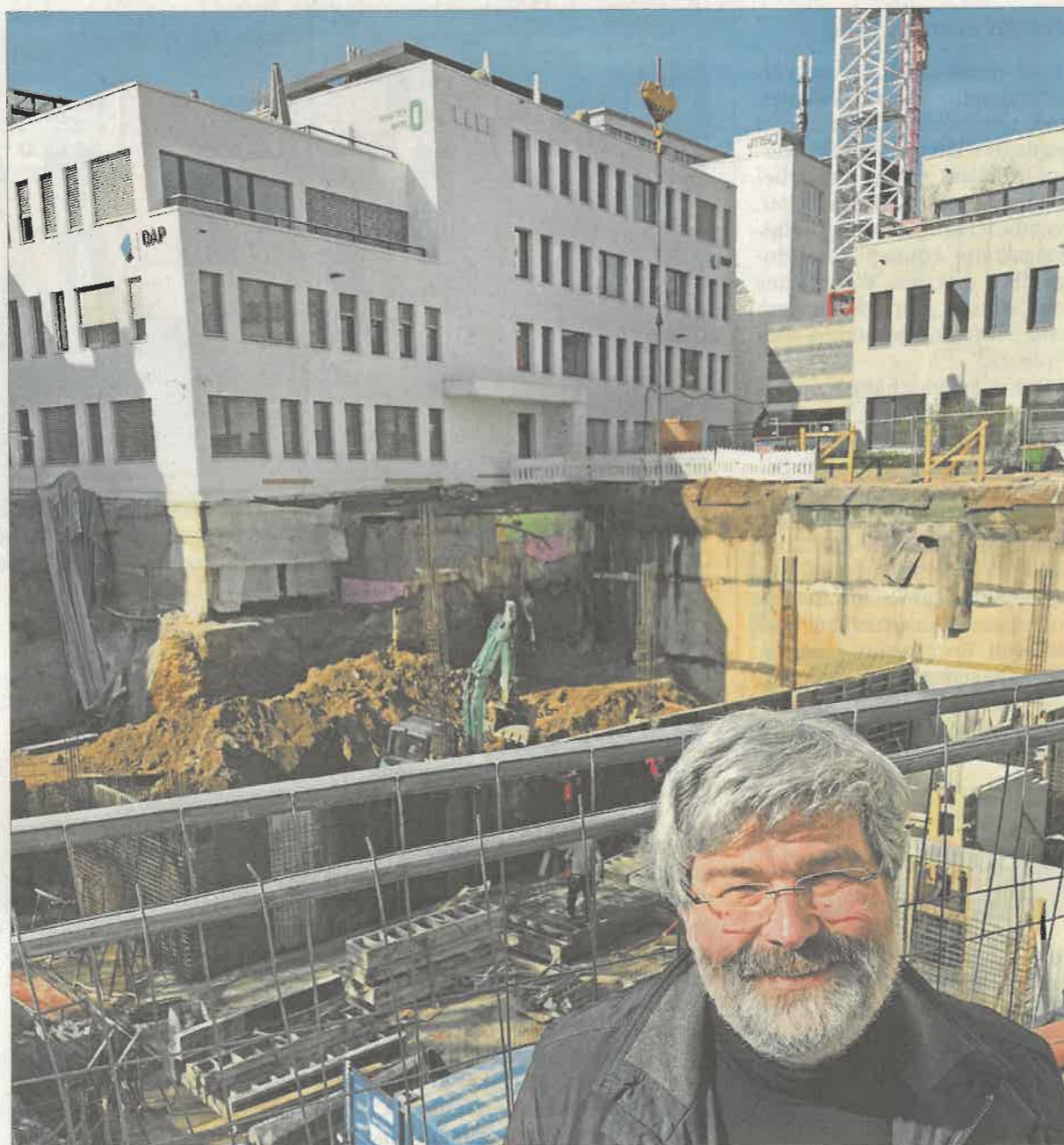
Acht Meter in die Tiefe reicht die neue Baustelle des Quartiers Mitte. Rudi Ramelsberger, Geschäftsführer der Kapfinger Immobilien GmbH, der das Projekt vorantreibt, plaudert aus dem Nähkästchen. – Foto: Fischer
