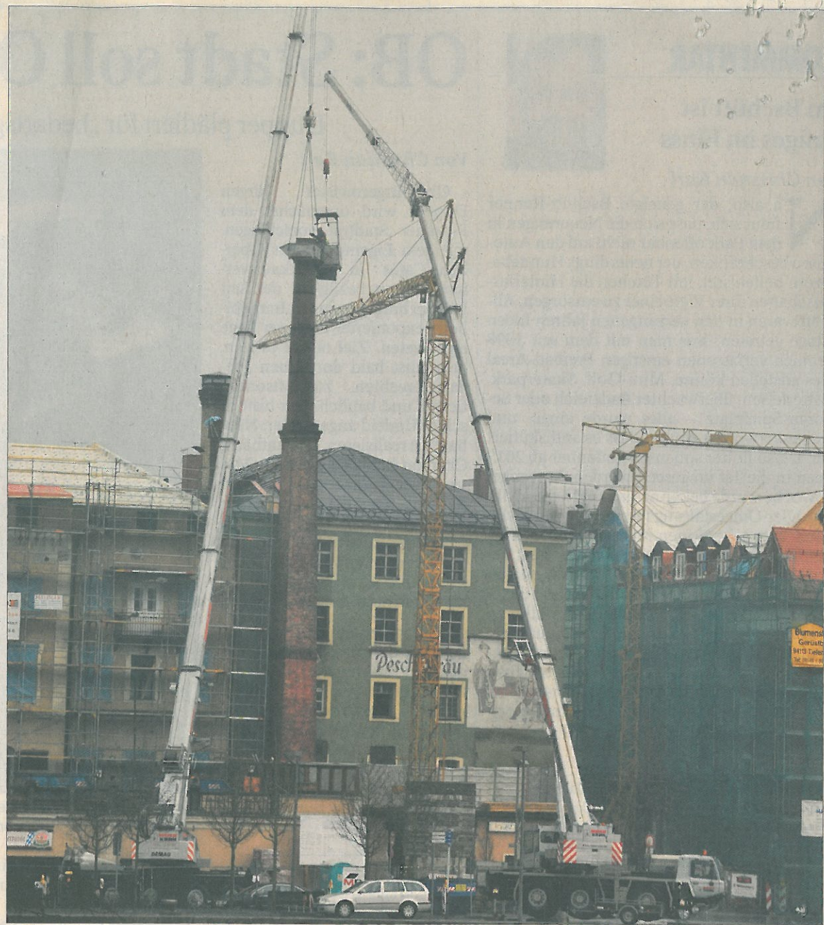
Zwei Autokräne vor dem Peschl-Bräu-Gebäude sind nötig für Kaminarbeiten.
