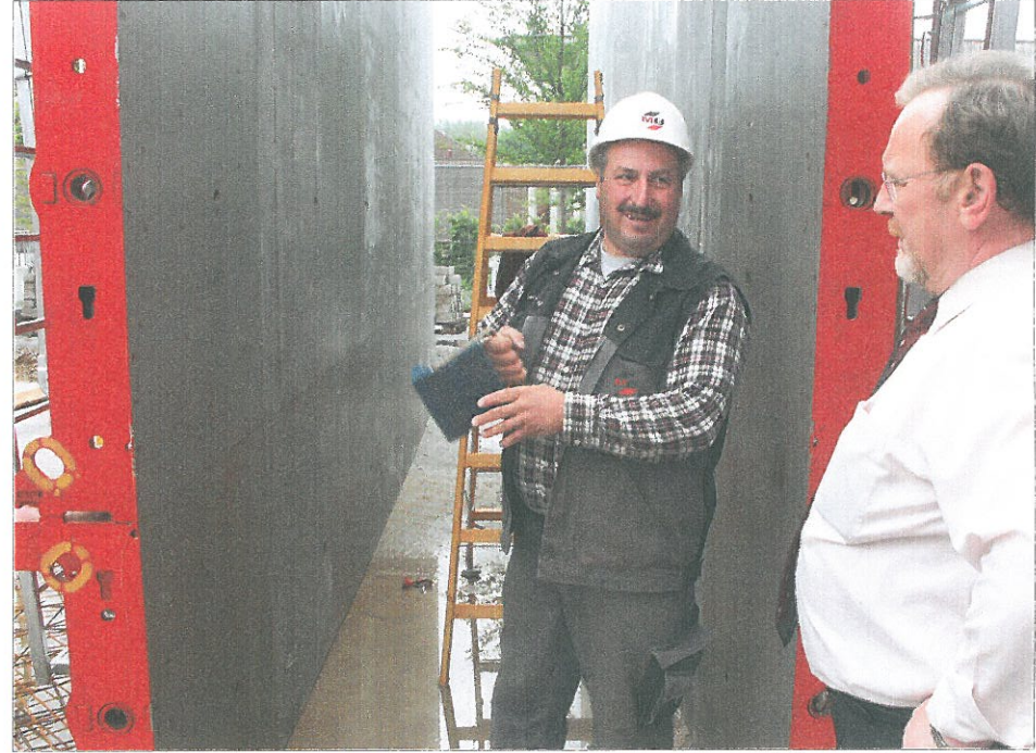
Polier Franz Bauer (links) demonstriert Rektor Hermann Langgartner zwischen den Schalungs-Elementen auf der Baustelle der St. Erhard-Schule die Wirkungsweise der Magneten. (Fotos: Schiller)
