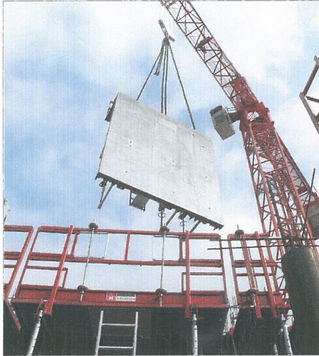
„Symphonie“ in Rot: Ein Kran hebt die Beton-Teile aus der Schalung. Die Metall-Elemente sorgen für einen zügigen Baufortschritt.
